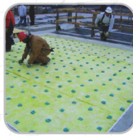
隔音浮式地板
